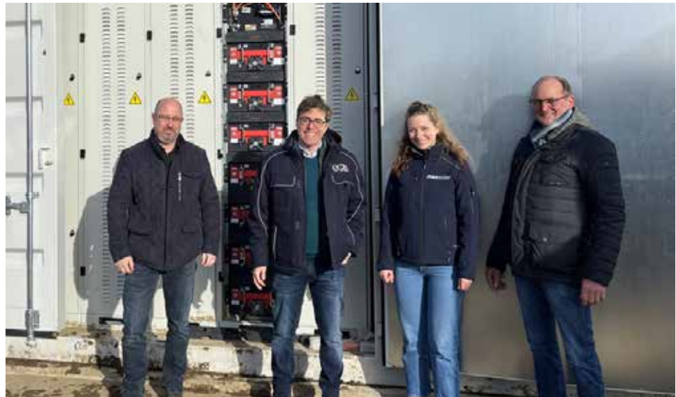
▲ Der innovative Großspeicher in Lehe. Es trafen sich beim Besichtigungstermin auf der Baustelle in Lehe (v.l.) Lars Brauns vom Gemeinderat, Pascal Lang EGIS eG Vorstandsvorsitzender, Frederieke Mevenkamp Projektentwicklung MaxSolar GmbH und Lehes Bürgermeister Rolf Thiede.
