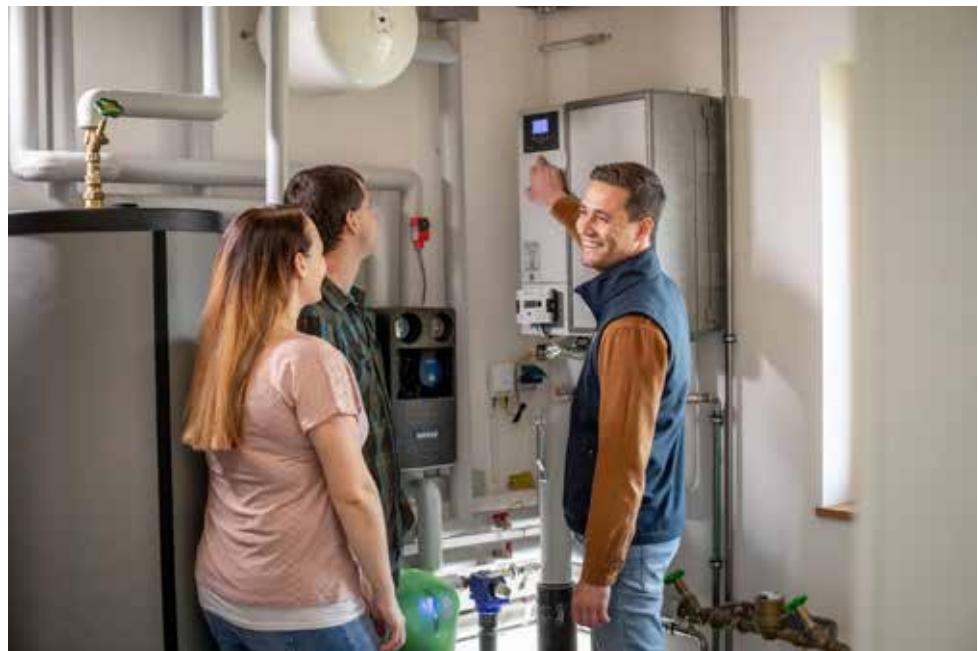
▲ Lukas Karl (r.) vom EGIS-Fernwärmeteam im Heizraum der Familie Giebl in Emmerting. Sie waren 2021 unsere erste „Fernwärmekundschaft“ und sind sehr zufrieden mit der sauberen und nachhaltigen Wärmeversorgung.
