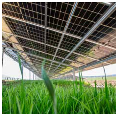
▲ Der Begriff „bifazial“ kommt aus dem Englischen und bedeutet wörtlich übersetzt „zweigesichtig“. Module dieser Art besitzen damit die Eigenschaft, sowohl die direkte Sonneneinstrahlung auf der Vorderseite, als auch indirektes Licht auf der Rückseite zur Stromerzeugung zu nutzen.
