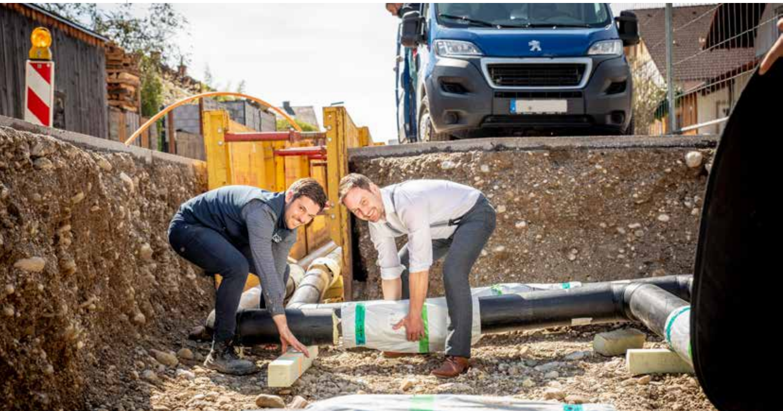
▲ Emmertings Erster Bürgermeister Stefan Kammergruber (r.) legt selbst Hand an – wenn auch nur zum Fototermin an der Baustelle in der Forststraße in Emmerting. Matthias Zimmermann, EGIS-Projektleiter der Fernwärme Emmerting, ist als direkter Ansprechpartner der Gemeinde immer vor Ort.
